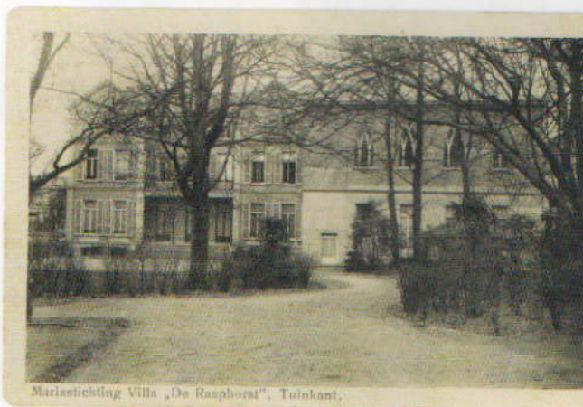
De aanbouw uit 1928 met de kapel
